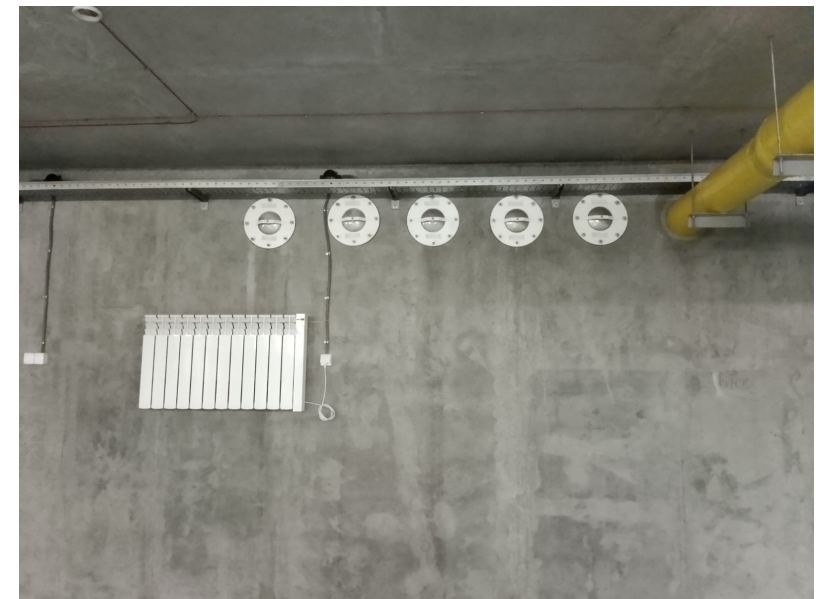
BVNC 300 8Y в захисній споруді
