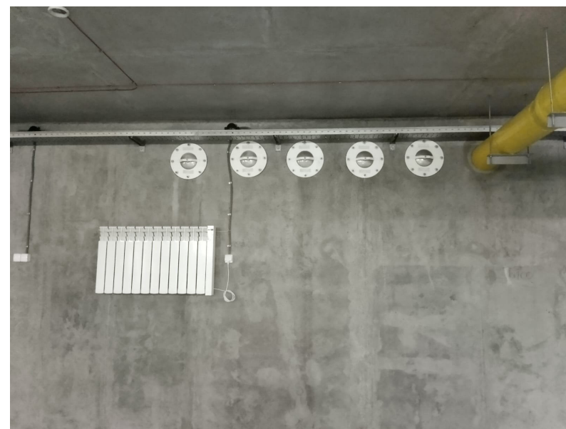
BVNC 300 8Y в захисній споруді
